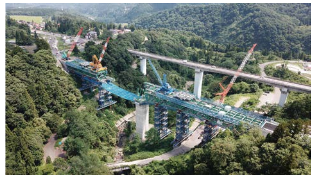
架設足場を主桁部材に取り付けてから架設
