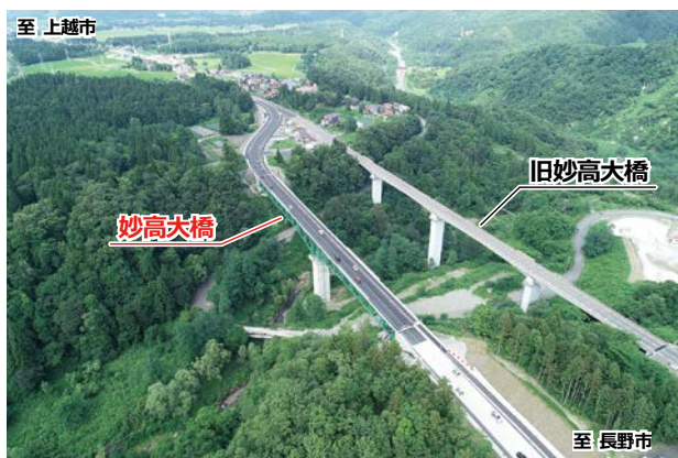
交通切替後の妙高大橋
