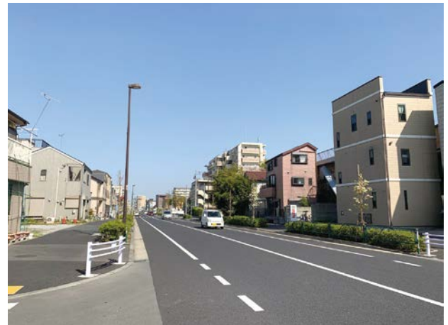
交通開放区間の状況
