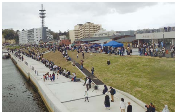
完成式で多くの市民が訪れた堤防一体空間
