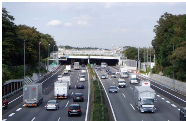
付加車線運用開始後の大和トンネル付近
