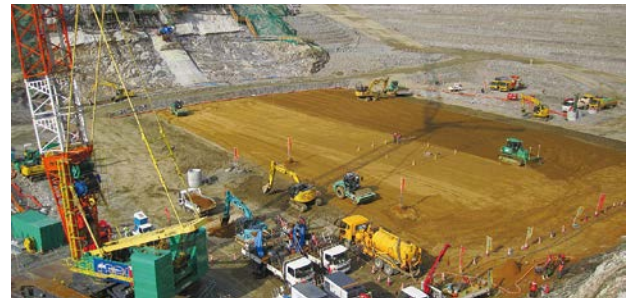
堤体盛立最盛期の小石原川ダム
