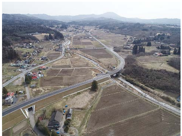
一般国道343号 渋民工区
