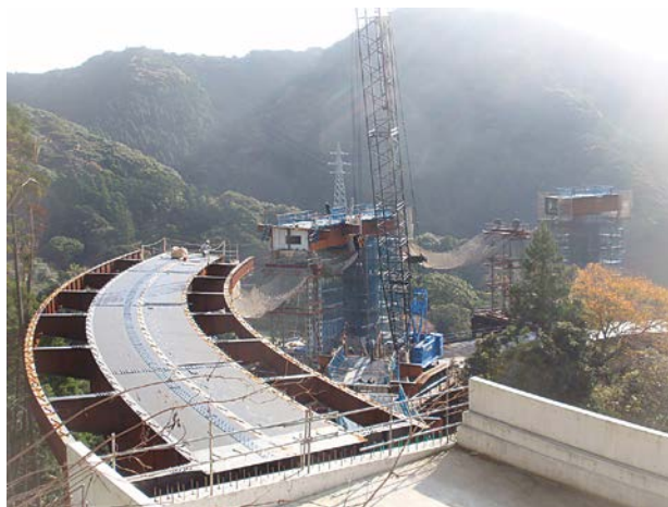
清澄山道ループ橋上部工区施工中
