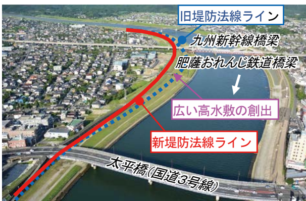
事業実施箇所（下流より望む）
