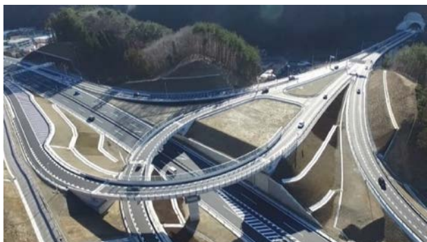
東北横断道釜石秋田線と三陸沿岸道路を繋ぐ「釜石ジャンクション」
