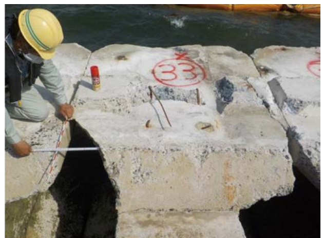
防波堤内部の直立消波ブロック損傷調査状況
