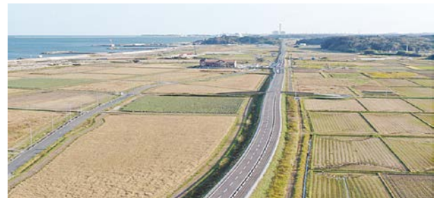
完成した「坂元・山寺復興道路」の様子
