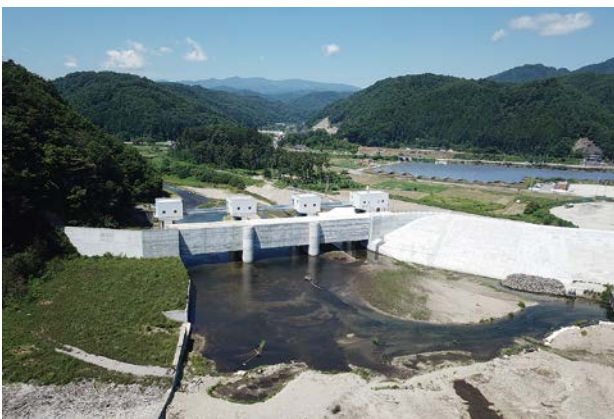
完成した田代川水門
