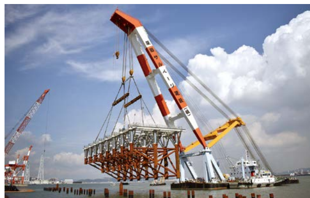
ジャケット据付状況
