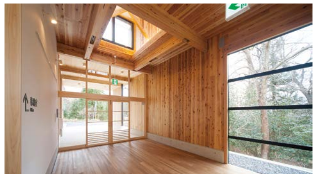
CLTパネル工法の採用
