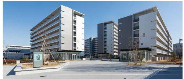
豊四季台団地第Ⅳ期 建て替え住棟の全景
