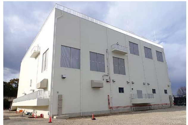
完成した呑龍ポンプ場
