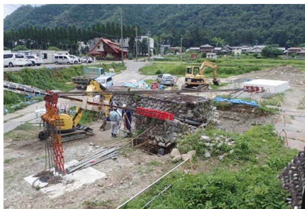
主索ケーブル仮吊及びアンカーレイジ補強
