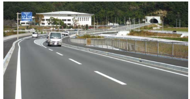
安中工区の開通後の様子
