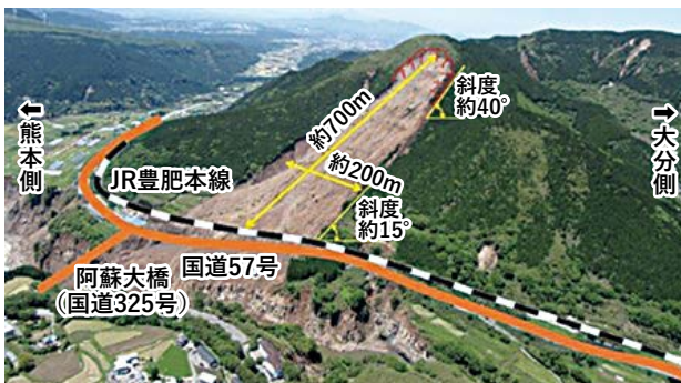
阿蘇大橋地区大規模斜面崩壊の概要
