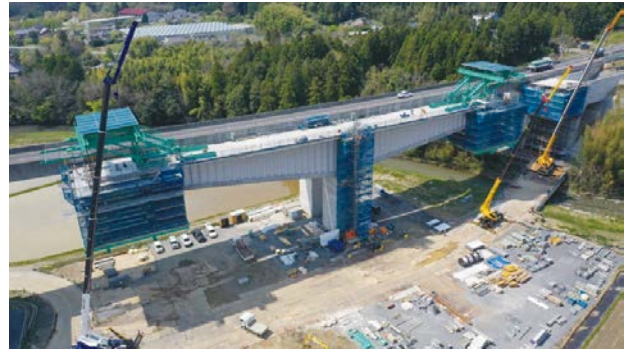
大型移動作業車による張出施工
