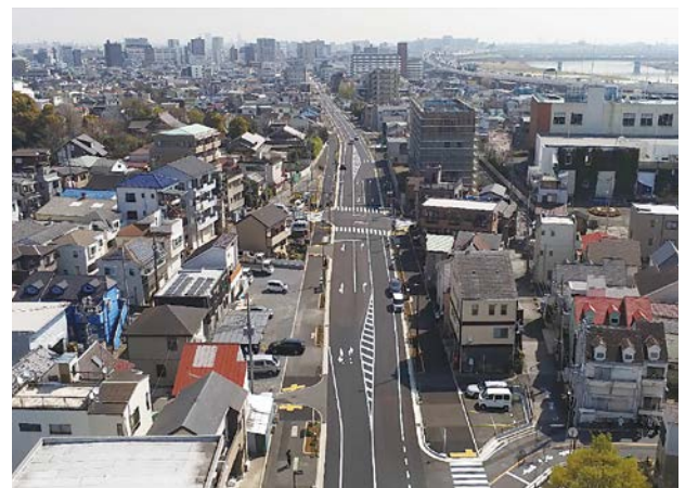
関原工区上空から東側を望む
