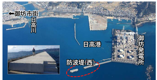
日高港防波堤（西）改良の状況
