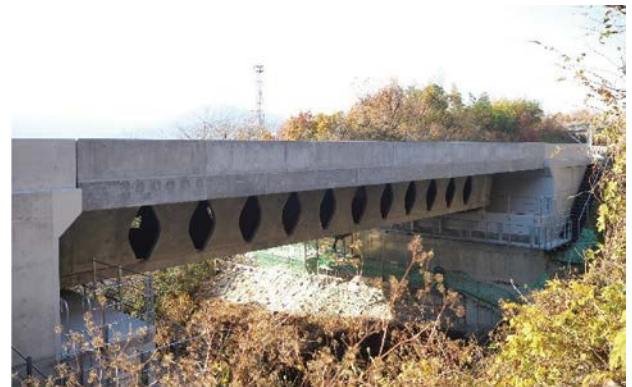
新技術を採用した別荘谷橋（完成）
