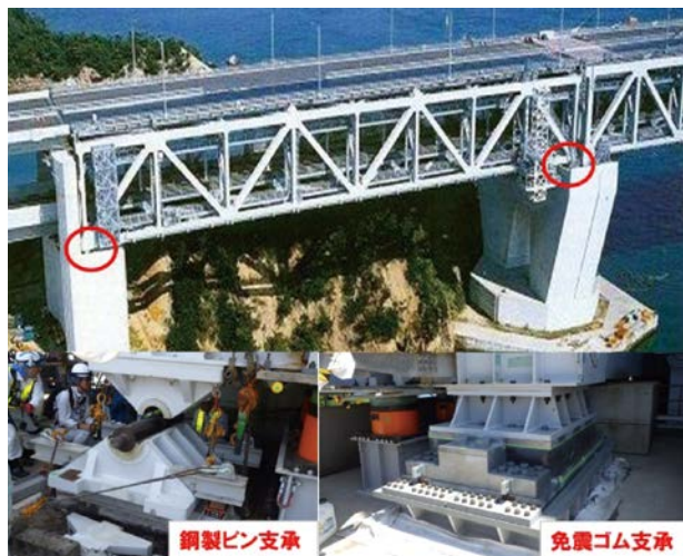
トラス橋の免震化（鋼製ピン支承→免震ゴム支承）
