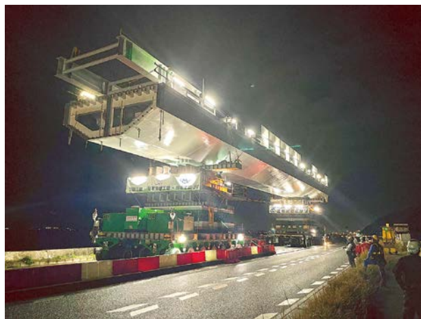
数久田ICオンランプ橋の橋桁運搬の様子
