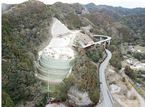
高さ約55mの補強土壁施工中
