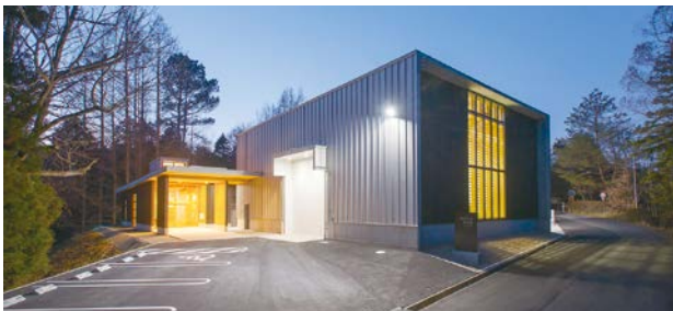
木造軸組工法とCLTパネル工法で整備した林業技術研修棟
