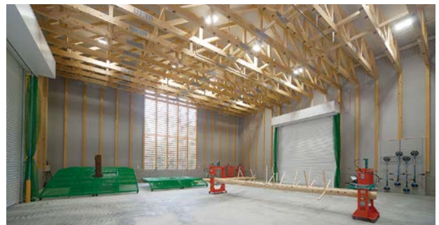
一般流通木材を使用した大空間
