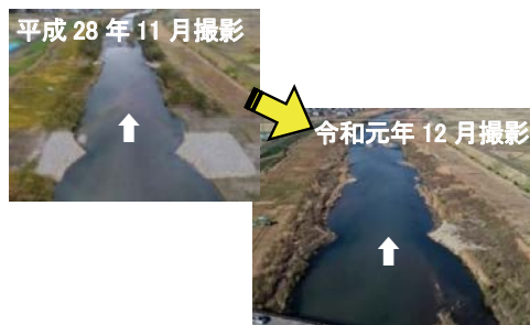
施工後の様子
