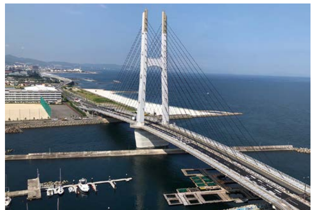
耐震補強 完成写真
