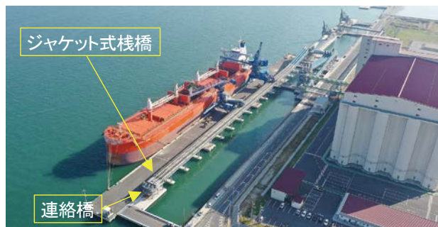
施設全景（ジャケット式栈橋と連絡橋）
