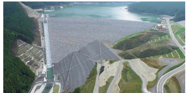
洪水時最高水位到達時の小石原川ダム（令和3年5月）
