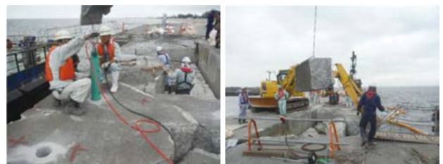
静的破碎工法による上部コンクリート取壊し状況
