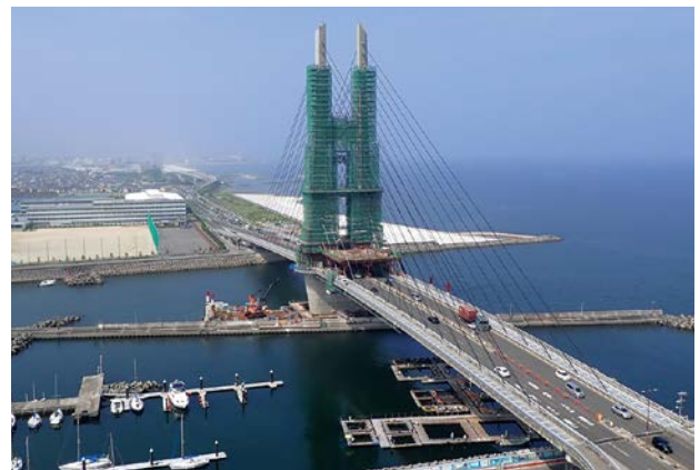
耐震補強 工事状況写真
