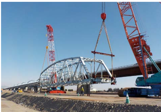
旧上武大橋撤去状況
