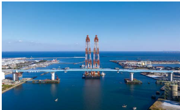
起重機船による架設の様子
