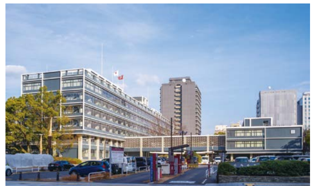
本館・玄関棟・南館西面（完成後）
