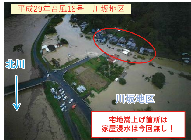
整備後の出水状況
