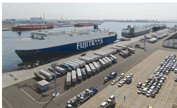
完成後の西ふ頭でのRORO船による荷役の様子
