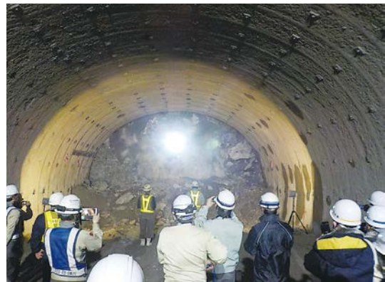
北沢トンネル実貫通（令和2年1月30日）
