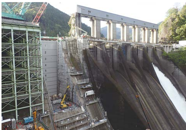
ダム運用管理を行いながらの大規模堤体切削の様子
