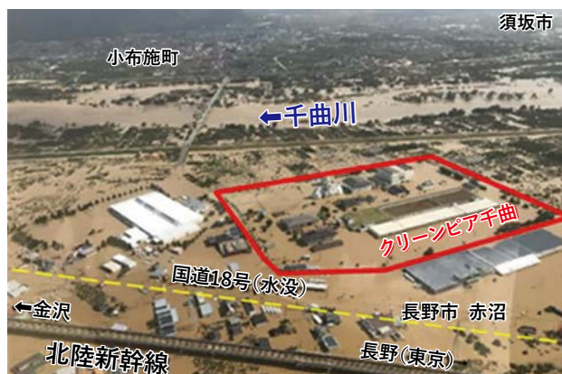
「クリーンピア千曲」浸水状況
