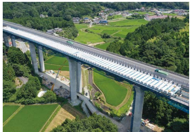
プレキャストPC床版による施工
